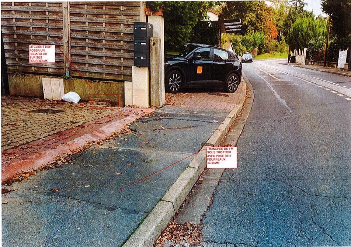
Tranchée de 7M sur trottoir et 1M sur chaussée pour percuter la K1C avec pose de 2 fourreaux de 45.
