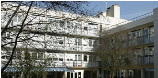
EHPAD - Résidence Montjoie 12 avenue Charles-de-Gaulle
